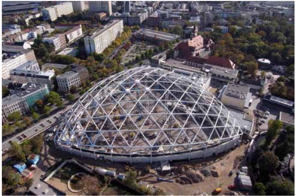
Tropenhalle Gondwanaland im Bau
